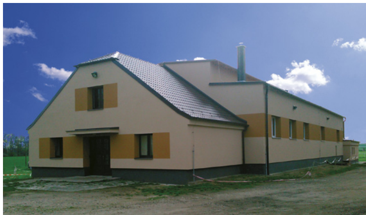
▲ Budova sokolovny po rekonstrukci. Foto: Zdeněk Jaroš
