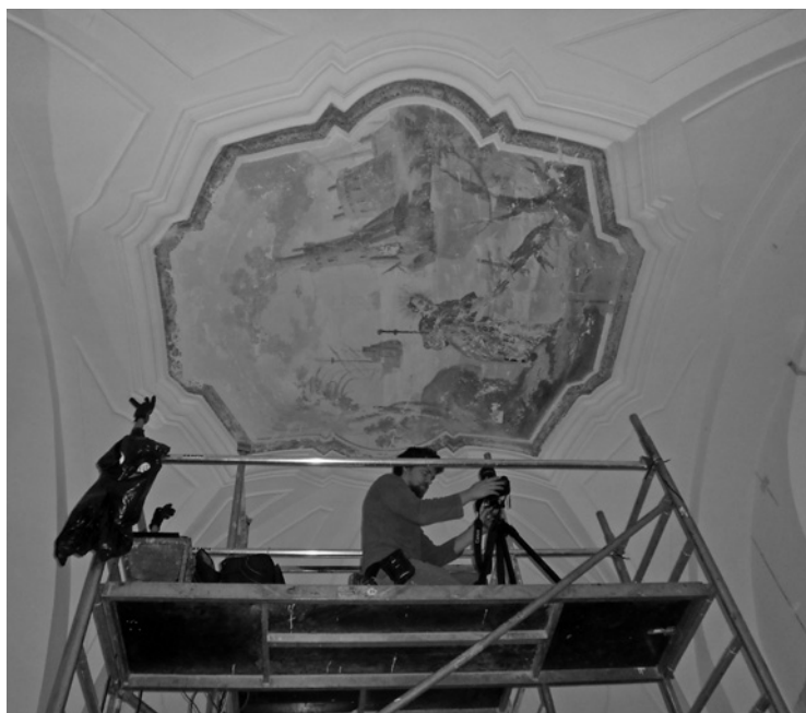
▲ Restaurátorské práce v kapli jsou v plném proudu. Foto: Petr Švasta
