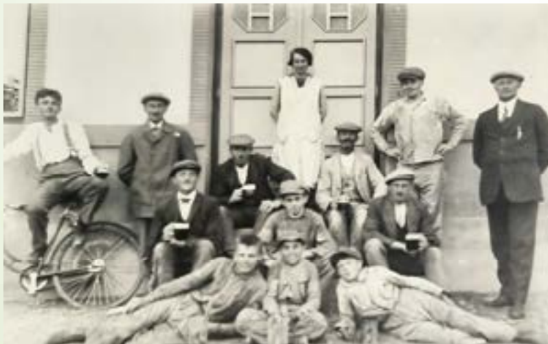
Brigádníci na stavbě
