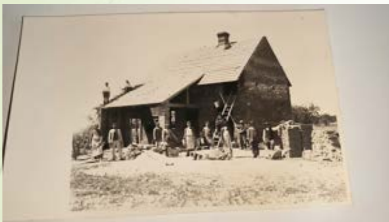
Stavba nové kovárny pro Josefa Sedláčka
